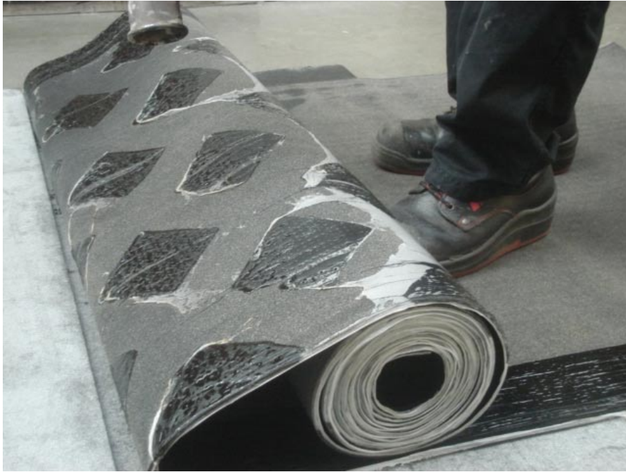
Figure 3 – Mise en œuvre du QUADRA ROCK
